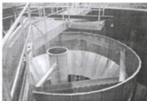
Montáž dosazovacích nádrží
