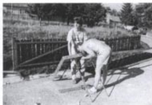
Příprava rámu a absorberu pro kolektor na škole v Nezdenicích
