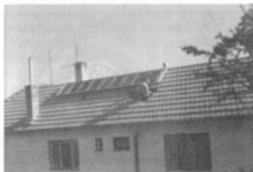
Sluneční kolektor těsně před dokončením
