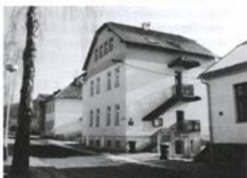
Budova Správy CHKO v Luhačovicích
