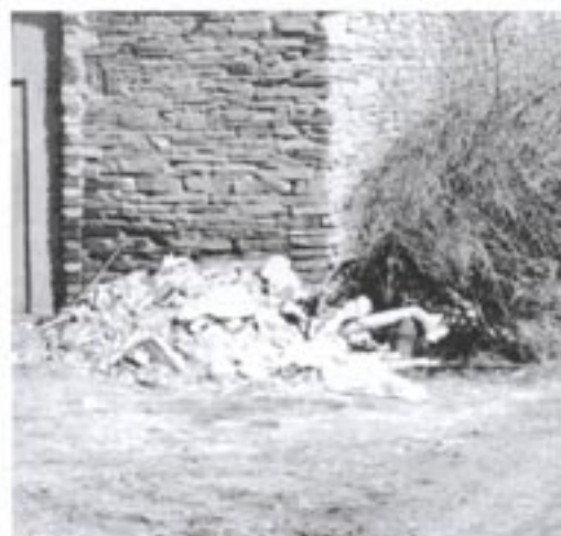
„Uklizené“ zbytky stavebního materiálu
