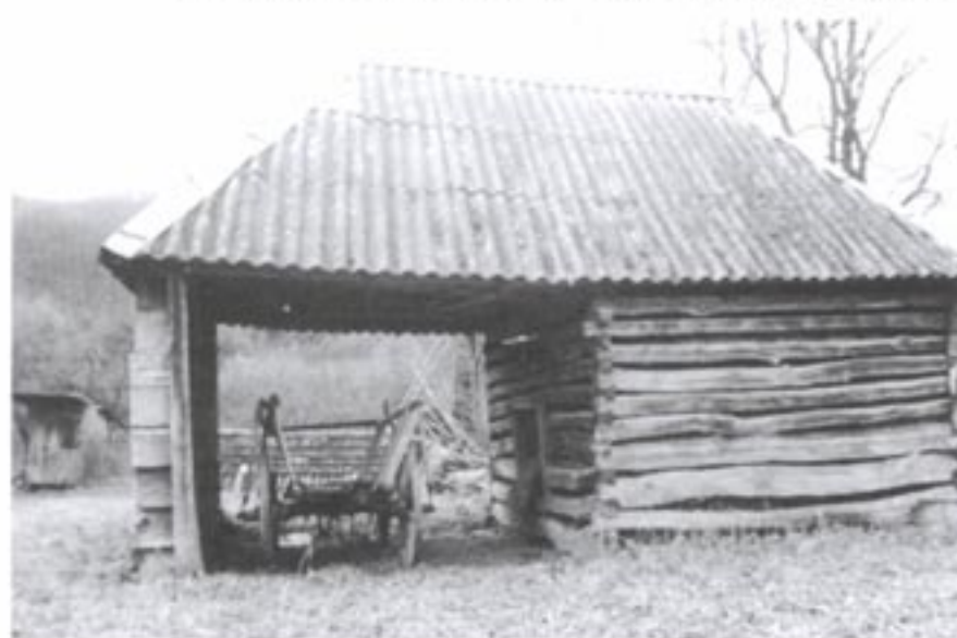
Senník starý približne dvesto rokov, ktorý bol v minulosti na lúke. Pri združstevňovaní bol demontovaný v päťdesiatych rokoch a zostavený znova v záhrade pri rodinnom dome v Moravskom Lieskovom na Plevovci. Pôvodná krytina došková bola nahradená azbestocementovou. Je ešte stále používaný.
