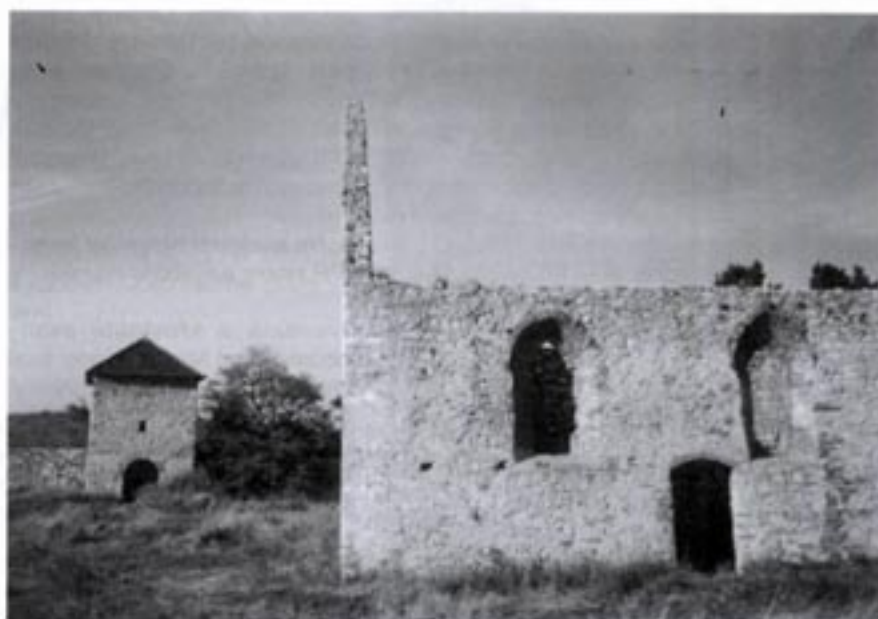
„Haluzický hrad“, ako kostol nazývajú staré listiny, ktorý je dnes bez strechy, stropu a omietky, bol pôvodne románskou stavbou. Po ďalších úpravách nadobudol podobu kostola v prechodnom románsko-gotickom štýle.
