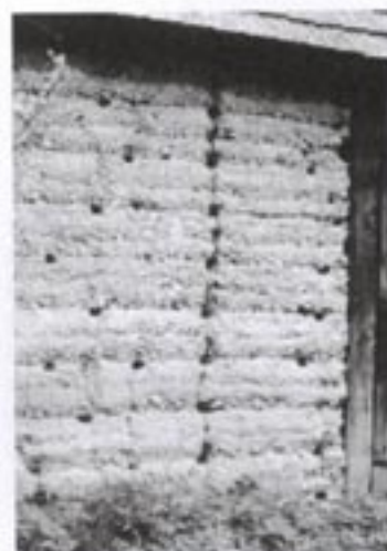
Nabíjaná stena s viditeľnými vrstvami a otvormi po rámoch. Zemianske Podhradie.
