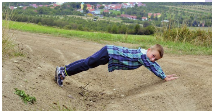
Polní cesta narušená vodní erozí a erozí rýhu do hloubky 70 cm nad Novou Lhotou (Foto Antonín Okénka)
