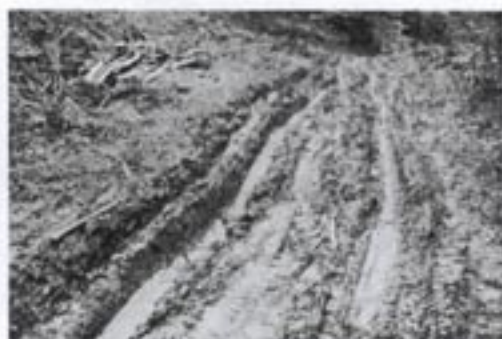
Nebezpečné erozní rýhy vznikají po průjezdu těžké techniky
